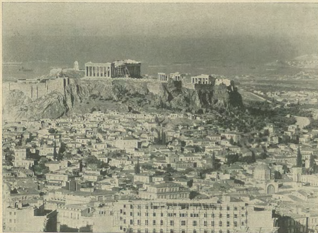
Abb. 3. Athen mit der Akropolis während der Wiederherstellungsarbeiten am Parthenon. Im Hintergrund das Meer, auf dem die griechische Kriegesflotte manövriert. (Bild v. W. Hege)
